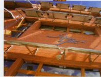
Vue Ineed Entrée Sud
