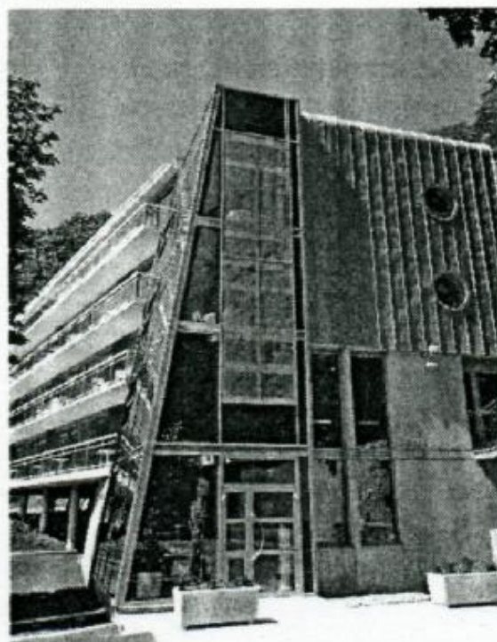
Cette réalisation est l'illustration d'une maîtrise de chantier «serrée».
