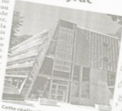
Cette réalisation est l'illustration d'une maîtrise de chantier «serrien».
