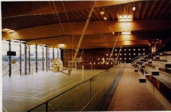
La salle omnisport dotée d'un plancher chauffant-rafraîchissant permet une vie sportive très active. ■
